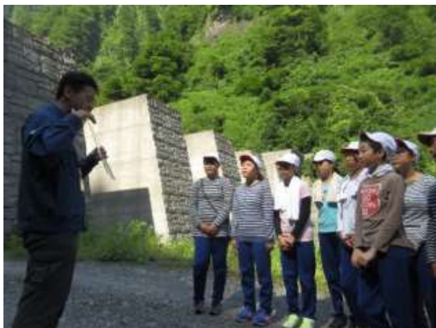
焼山川 1 号砂防堰堤 スリット式ダムの見学
