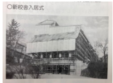
昭和 56 年現校舎の工事風景
