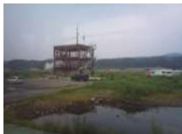
防災対策庁舎（車窓より撮影）
